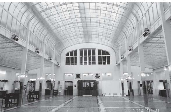
出納窓口ホール。天井の上に鉄骨トラス。上に切り妻ガラス屋根
