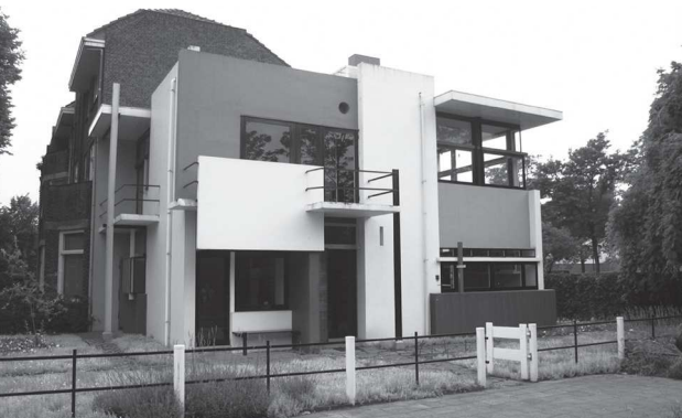
南東側外観 左側に街路がある。右上、居間・食堂
