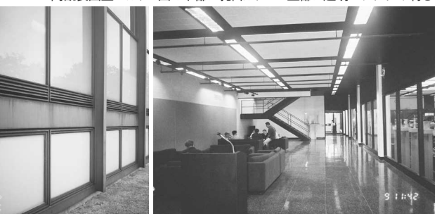
左:外部サッシュ周り 3mピッチのH型鋼の方立補強 下部は半地下の採光窓 右:半地下の談話ラウンジ。右側は図書室
